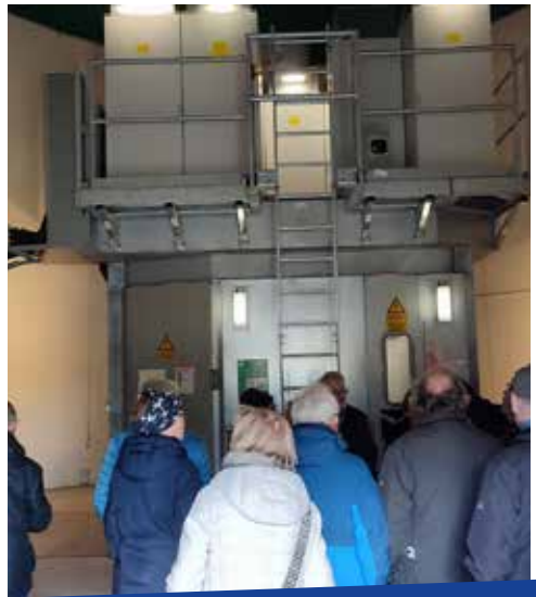
Die Gemeinde Saerbeck betreibt eine eigene Windkraftanlage, die wir während der Führung von Innen besichtigen konnten!
