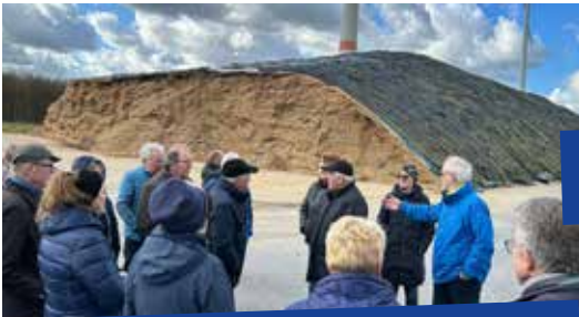
Die Biogasanlage betreiben 17 ortsansässige Landwirte in Eigenregie, ein riesiges Areal auf dem Gelände!
